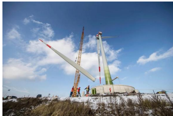
Figura 2. Montaje de un álabes de aerogenerador (Schmidbauer, 2026).
