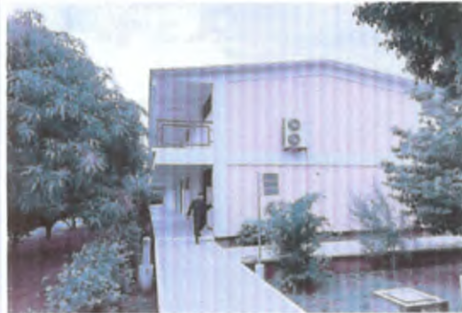
EDIFICIO DE SALA AUDIOVISUAL
