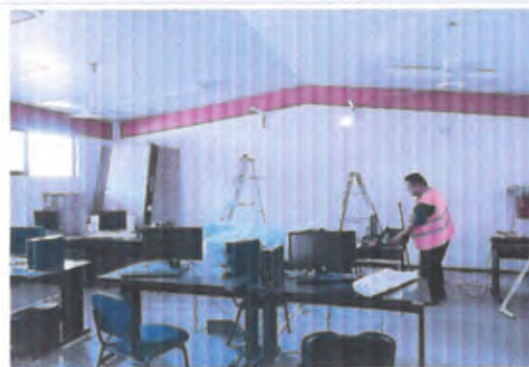
COLOCACIÓN DE SOPORTES PARA EVAPORADOR SALA DE CÓMPUTO DE DISEÑO
