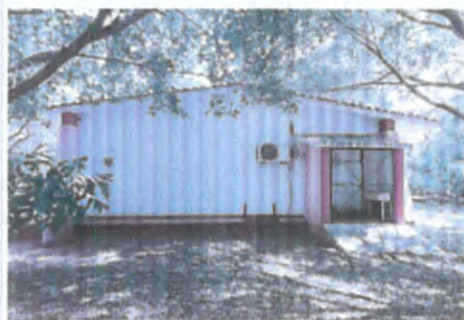
UNIDAD CONDENSADORA ACTUAL
