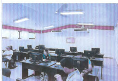
COLOCACIÓN DE EVAPORADORES
