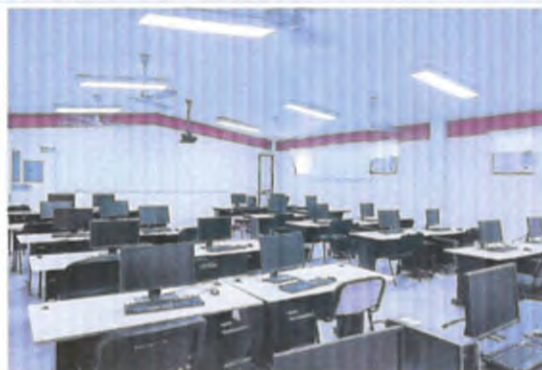
UBICACIÓN DE EVAPORADORES
