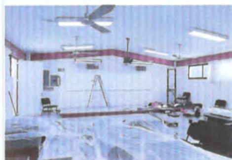
SUMINISTRO Y COLOCACIÓN DE EVAPORADORES
