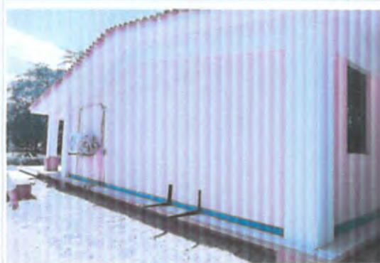
MURO PARA COLGAR LA UNIDAD CONDENSADORA
