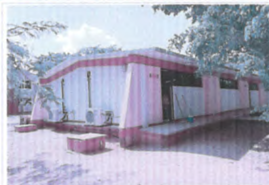
SUMINISTRO Y COLOCACIÓN DE CONDENSADORES
