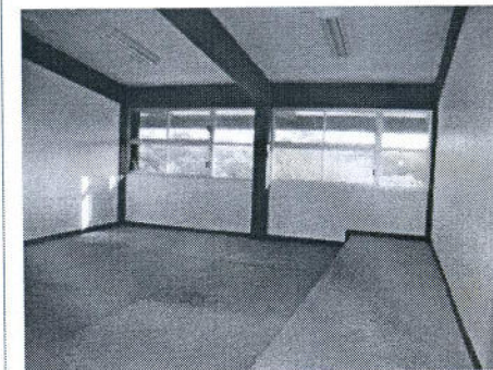
Vista interior aulas 07/05/2012
