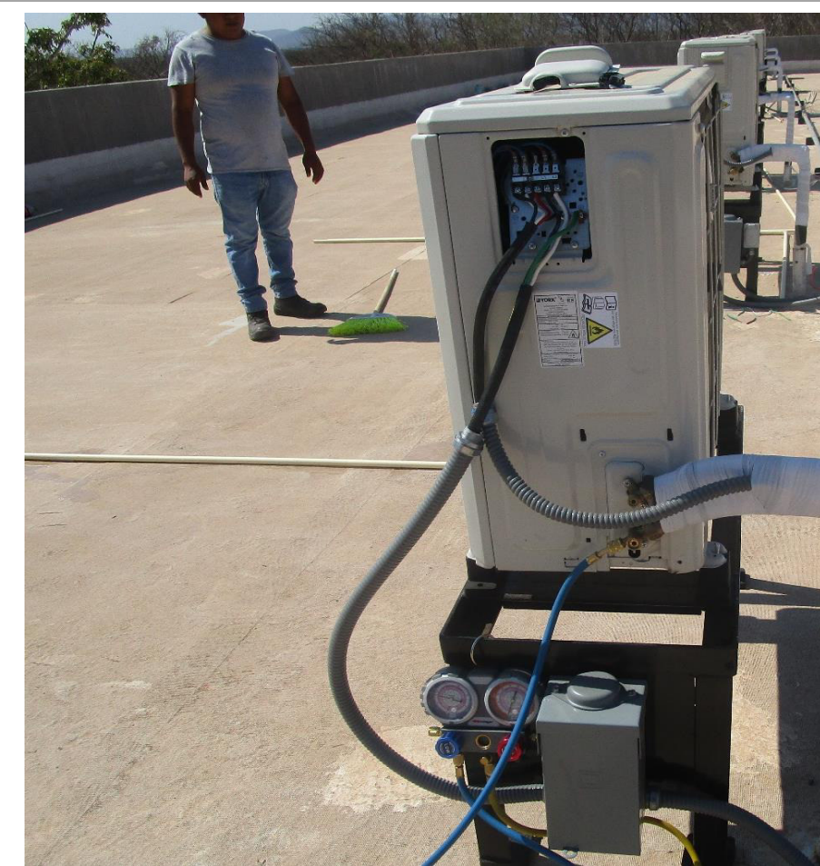
Pruebas de presión para detectar fugas de gas refrigerante a los equipos de aire acondicionado inverter de 36,000 BTU's tipo cassette.
