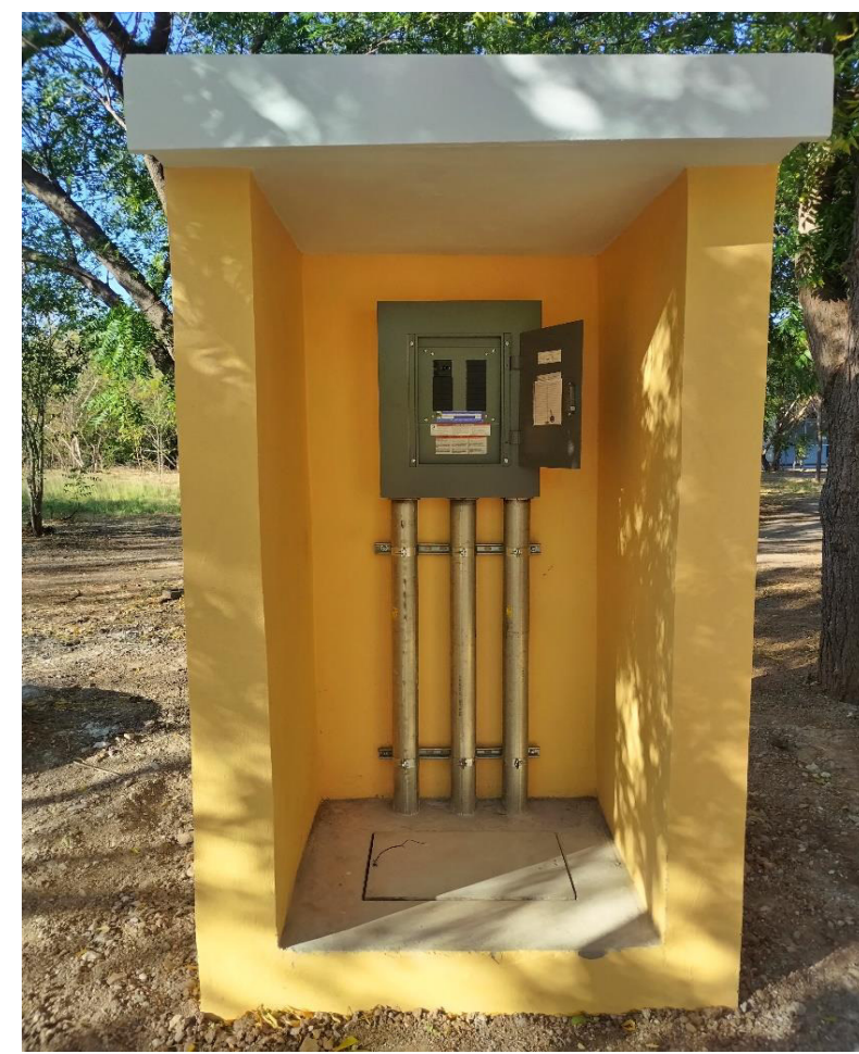
Construcción de nicho de concreto y suministro e instalación de tablero eléctrico en el I.E.C.A.
