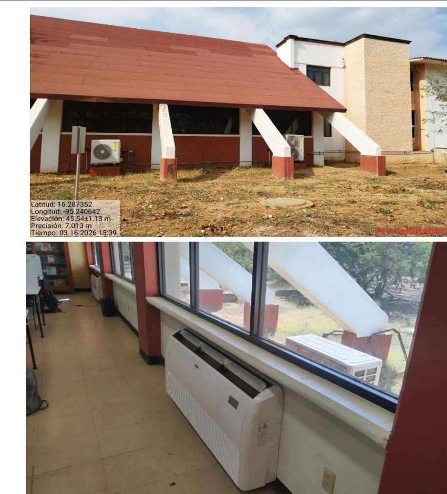
Suministro e instalación de aires acondicionados inverter de 60,000 BTU's tipo piso-techo.
