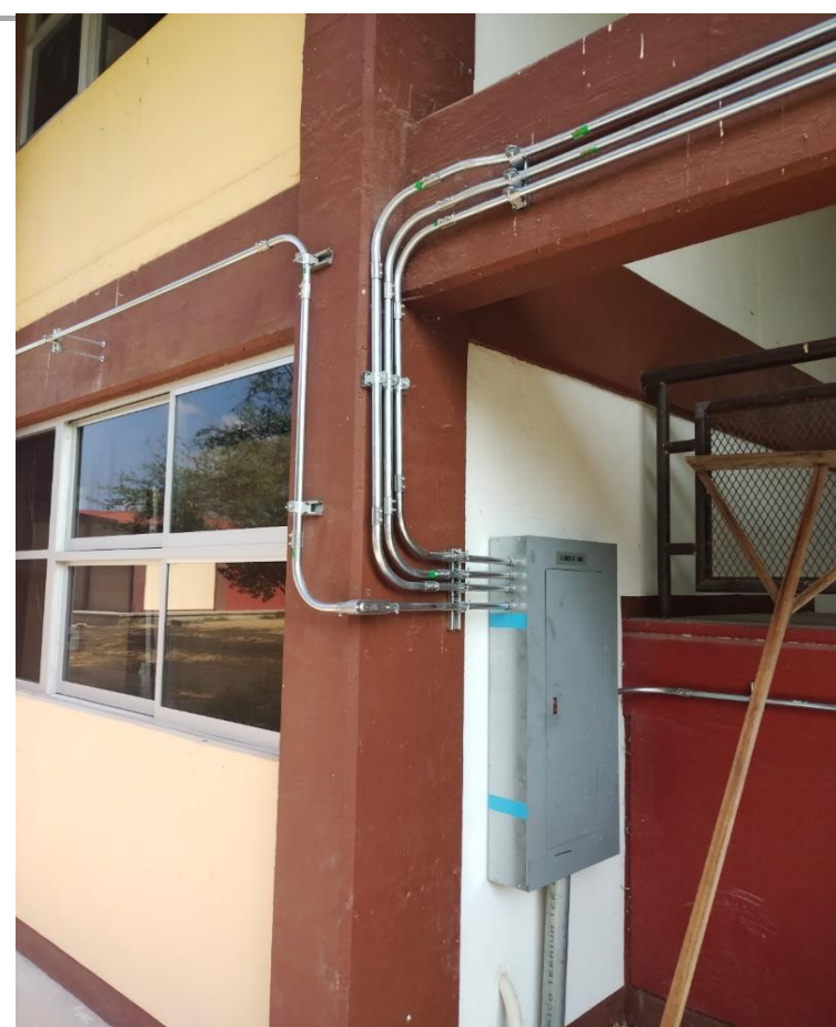
Suministro y colocación de centros de carga QO2, interruptores termomagnéticos y contactos de servicio para aires acondicionados de 36,000 y 60,000 BTU's.
