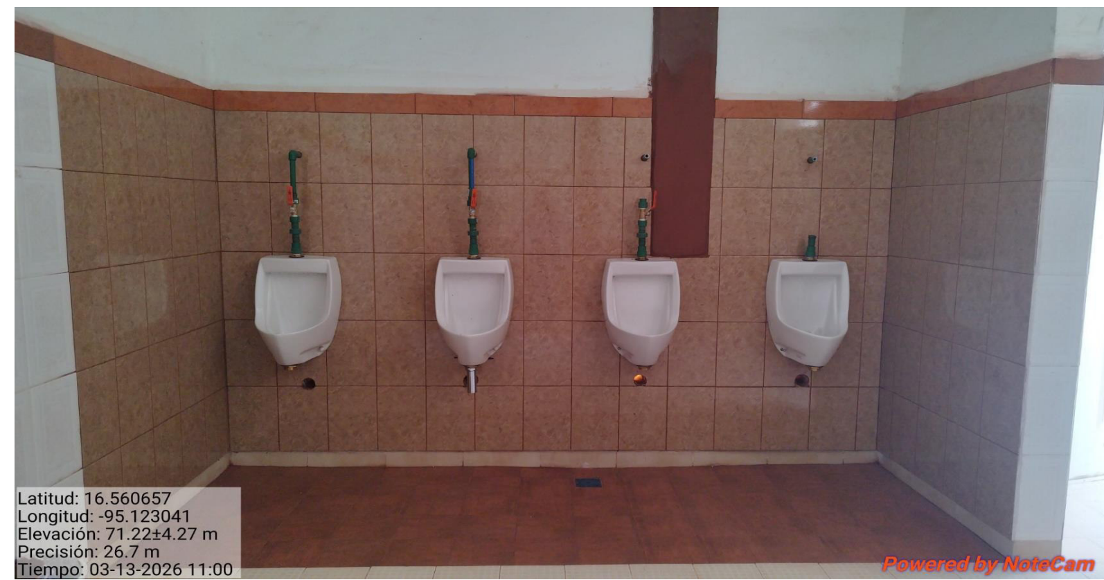
Suministro y colocación de mingitorios en baños generales del Campus Ixtepec
