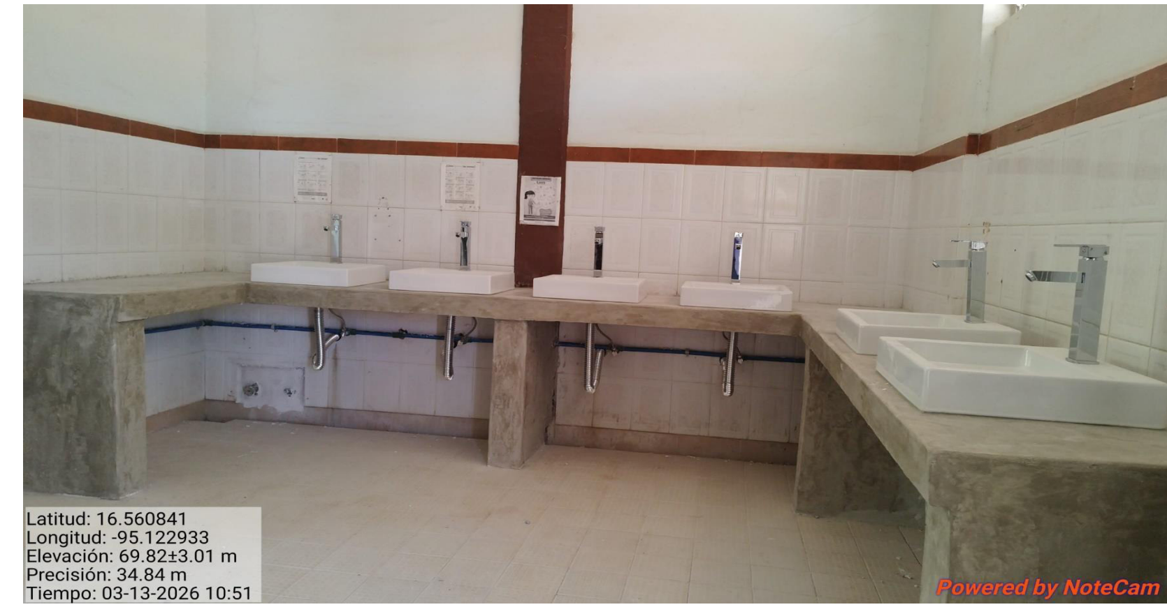
Construcción de meseta Suministro y colocación de lavabos en baños generales del Campus Ixtepec
