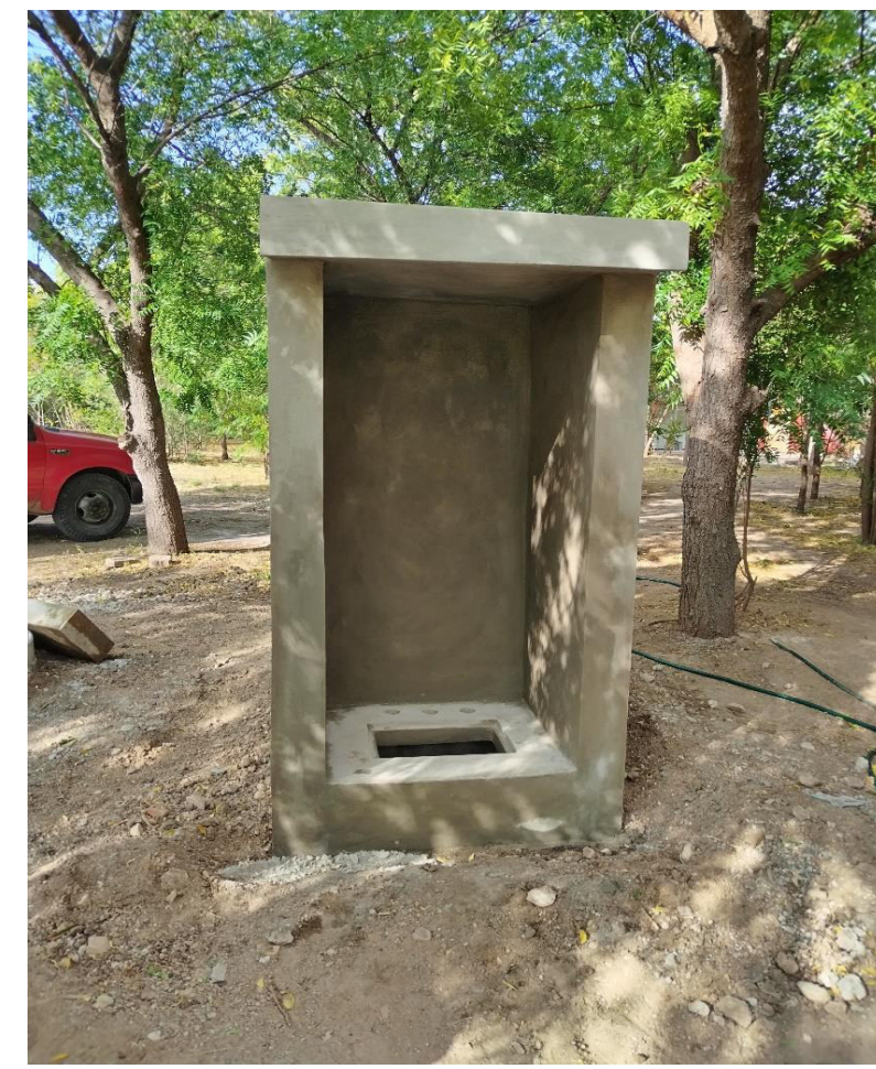
Construcción de nicho de concreto y suministro e instalación de tablero eléctrico en el I.E.C.A.
