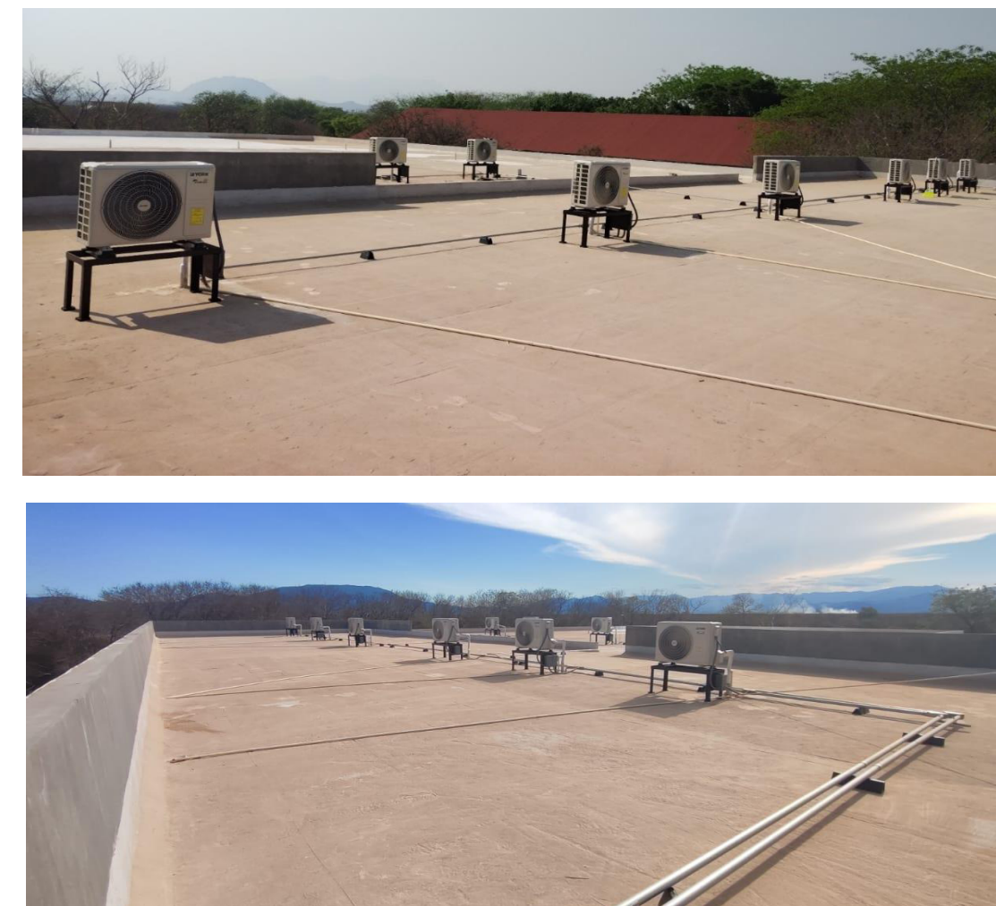
Suministro e instalación de aires acondicionados inverter de 36,000 BTU's tipo cassette.
