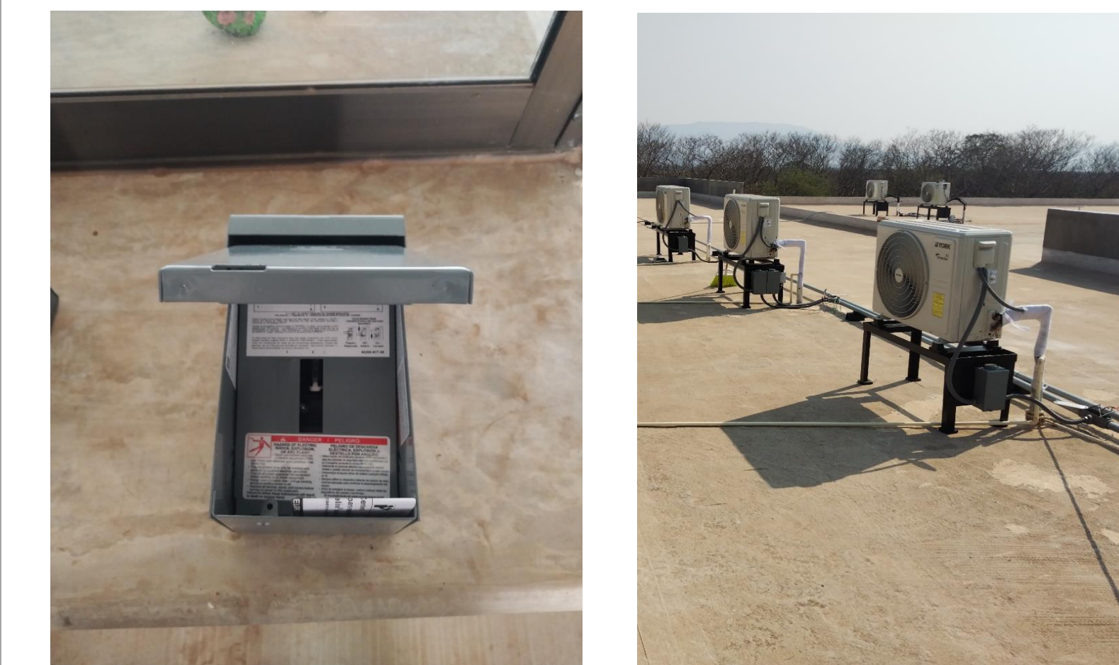
Suministro y colocación de centros de carga con interruptor termomagnético de 2 polos de 30 amperes e instalación de contactos de servicio.
