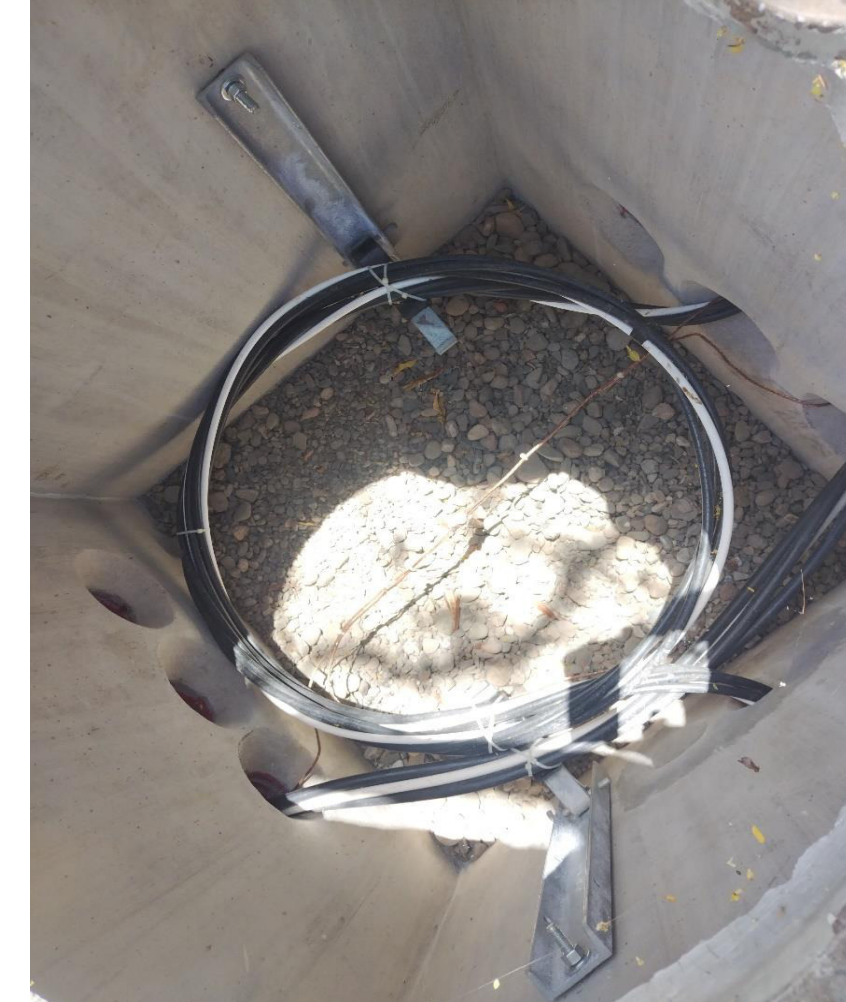
Suministro e instalación de sistemas de tierra en registros de baja tensión y pruebas de aislamiento del conductor.
