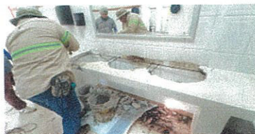
Trabajos de demolición de meseta para lavabos en baños generales Campus Ixtépec.
