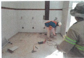
Trabajos de desmonte de mingitorios en baños generales del Campus Ixtépec
