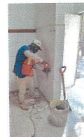
Trabajos de demolición de azulejos en baños generales del Campus Ixtépec
