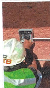
Suministro y colocación de interruptor termomagnético de 1 polo de 20 amperes.
