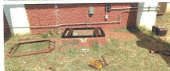
Salida eléctrica para aire acondicionado inverter tipo piso-techo y contactos del tablero principal al centro de carga.
