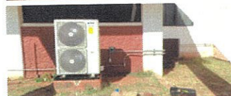
Suministro e instalación de equipo de aire acondicionado tipo piso-techo, marca york, carrier, o con características similares o superiores, 50,000 btu, inverter, solo frío 220/60, refrigerante r410a.
