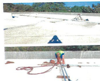
Suministro e instalación de tubería y cable thhw-ls cal. 10, 12 awg en salida eléctrica para aire acondicionado inverter.
